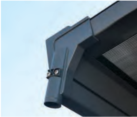
Minden sarkában beépített vízvezető csatorna van.
