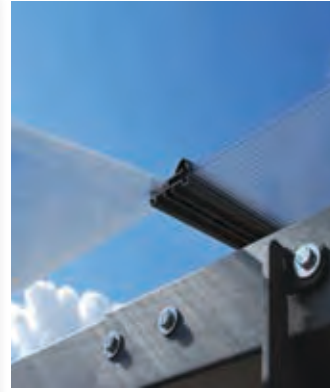
Egyszerű tetőpanel rögzítés
